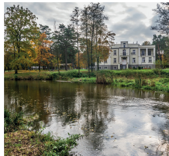
Gmina ubiega się m.in. o dofinansowanie remontu dachu Konstancińskiego Domu Kultury, fot. A. Piętko
