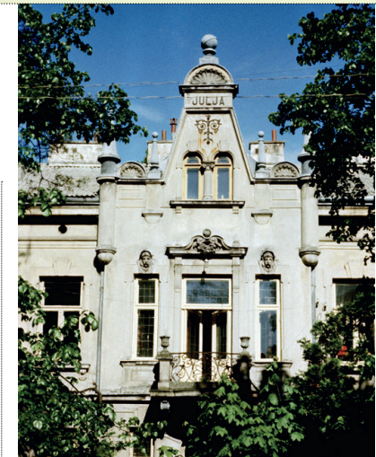
Julia. Elewacja frontowa – detal. Fot. Julian Henisz
