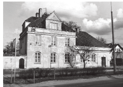
Klarysew – stacja kolejki dojazdowej (obecnie poczta), 1990. Archiwum WUOZ w Warszawie
