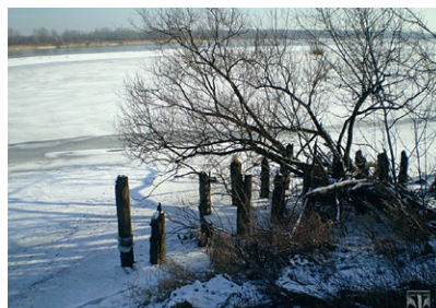
Pozostałości mostu w Ciszycy.
