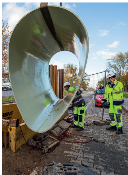
Nowe moduły rurowe, umieszczane w kanale sanitarnym, będą miały średnicę 800 mm, fot. Archiwum firmy Aquaren
