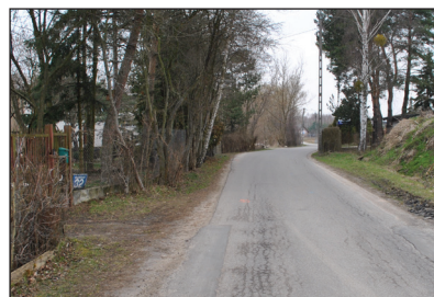
Budowa sieci ma ruszyć na dniach Fot. G. Żurawski
