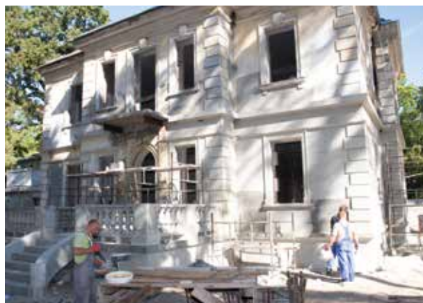
Pracownicy na plac budowy wrócili z początkiem kwietnia, fot. G. Żurawski
