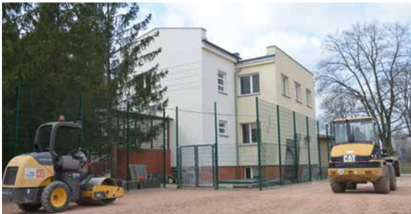
Obecnie trwają prace przy budowie boiska wielofunkcyjnego, fot. G. Żurawski
