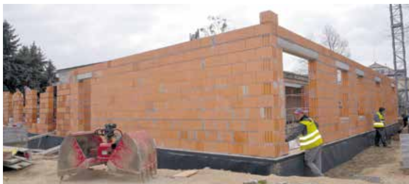
Na placu budowy trwają intensywne prace budowlane, fot. G. Żurawski
