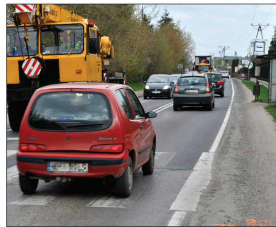
Remont drogi nr 721 to konieczność Fot. G. Żurawski
