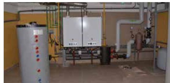
Remont kotłowni w SP nr 2, fot. Cezary Puchniarz
