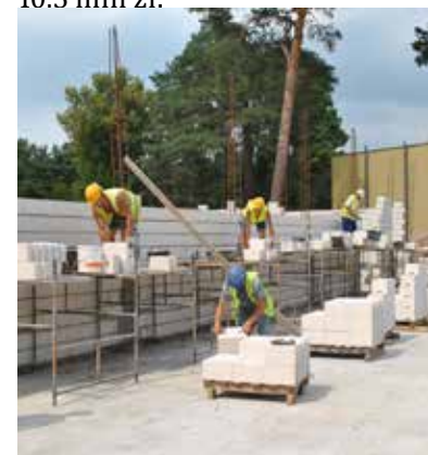
Budowa sali gimnastycznej przy SP nr 1, fot. Archiwum UMiG
