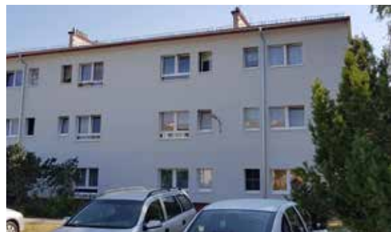
Budynek przy ul. Brzozowej 2D po remoncie dachu i termomodernizacji, fot. ZGK
