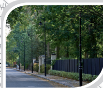
Kompleksowa przebudowa dróg
