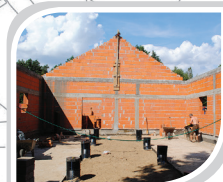
Kontynuacja budowy stacji uzdatniania wody Warecka
