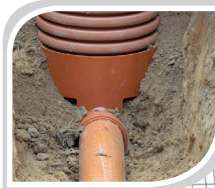
Kontynuacja budowy sieci wod-kan: Skolimów ptn.-zach, wsie południowe
