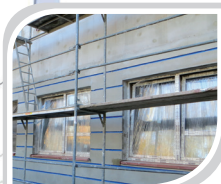
Budowa sali gimnastycznej w Opaczy
