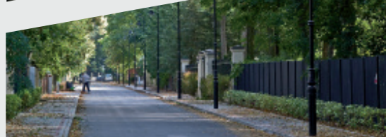
Remonty i budowa dróg
