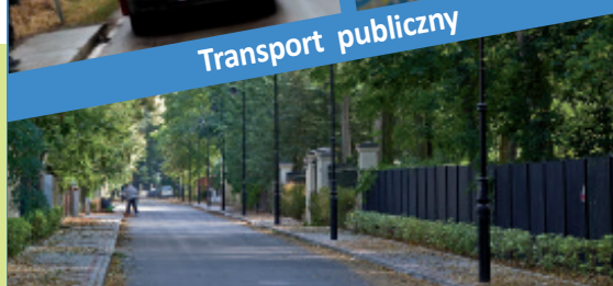
Remonty i budowa dróg
