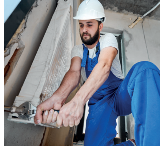
Dofinansowaniu podlegają koszty przeprowadzenia modernizacji systemu ogrzewania wewnątrz budynku lub lokalu mieszkalnego, fot. UMIG
