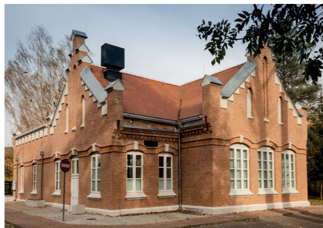
Dom Ludowy przeszedł gruntowny remont, teraz będzie się w nim znajdowało Muzeum Wycinanki, fot. D. Fręc
