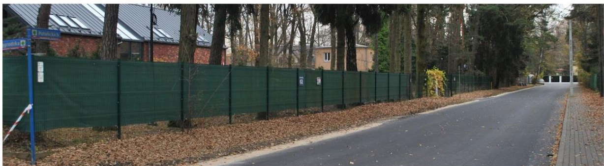
Nowy asfalt na ul. Potulickich
