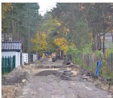
Budowa ul. Mostowej i Łącznej
