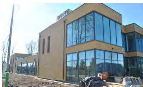
Przebudowa Szkoły Podstawowej w Słomczynie
