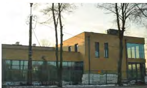
Przebudowa Szkoły Podstawowej w Słomczynie
