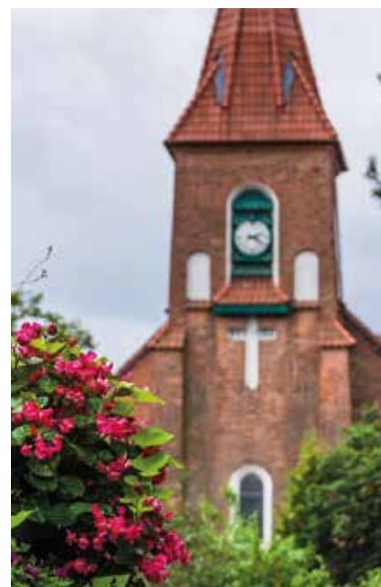
Kościół pw. Wniebowzięcia NMP został wzniesiony w 1913 r., fot. A. Piętko
