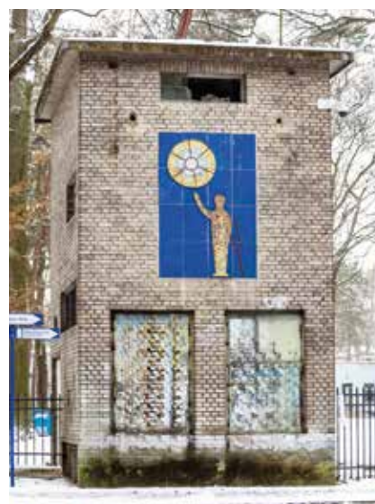
Mozaika umieszczona jest na elewacji nieczynnej stacji transformatorowej przy ul. Wierzejewskiego 12a, fot. A. Piętko
