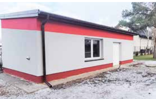
Pod koniec listopada zakończył się remont budynku gospodarczego przy Ochotniczej Straży Pożarnej w Bielawie, fot. UMIG
