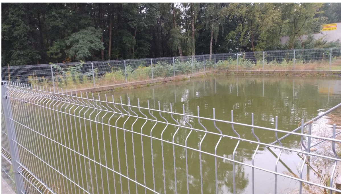
Fot. 4 Zbiornik retencyjny na deszczówkę przy sklepie LIDL po 30 mm opadu (22.10.2023).
