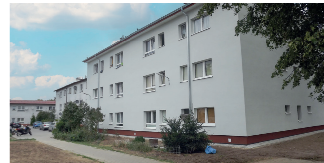
Budynek przy ul. Brzozowej 2 D po remoncie dachu i termomodernizacji, fot. Archiwum ZGK
