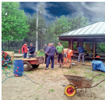
W Czarnowie, w ramach inicjatywy lokalnej, mieszkańcy wybudowali altanę na placu sołectkim, fot. C. Żegliński
