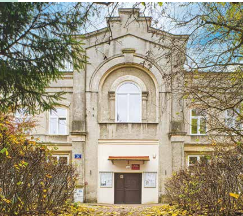
Budynek dawnej Szkoły Powszechnej | The building of the former Primary School
