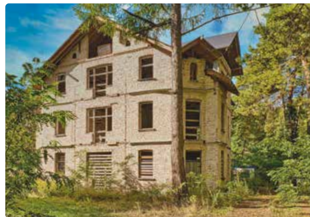
Willa Zbyszek w trakcie rewitalizacji, 2024 r. | Villa Zbyszek undergoing revitalization, 2024
