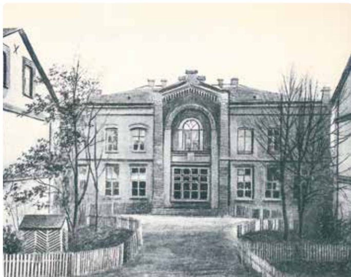
Budynek Szkoły Powszechnej, przełom XIX i XX wieku | Building of the Primary School
