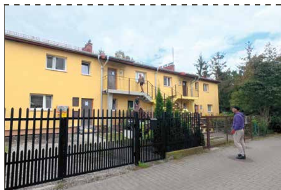
→ Termomodernizacja budynków przy ul. Mirkowskiej 48B i 48C jest już na finiszu B. Niżyńska
