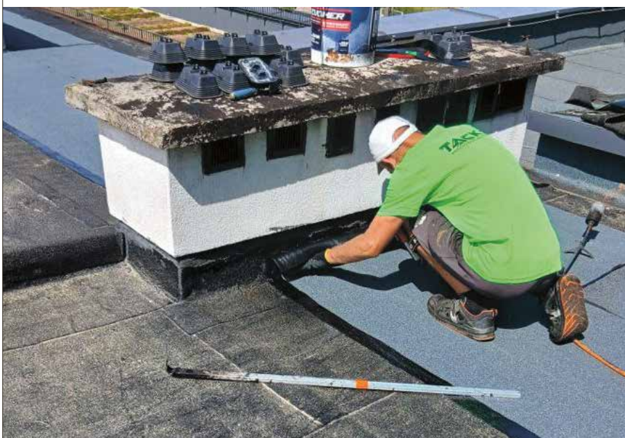
→ W Szkole Podstawowej nr 4 w Słomczynie odnowiono dach na starszej części budynku 📍 Archiwum szkoły
