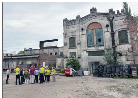
➔ Firma Arche realizuje obecnie pierwszy etap inwestycji na osiedlu Mirków 📍 UMiG
