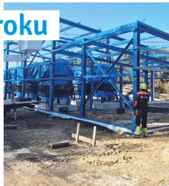
➤ Trwa budowa Stacji Uzdadniania Wody Nowe Wierzbno / fot. UMiG
